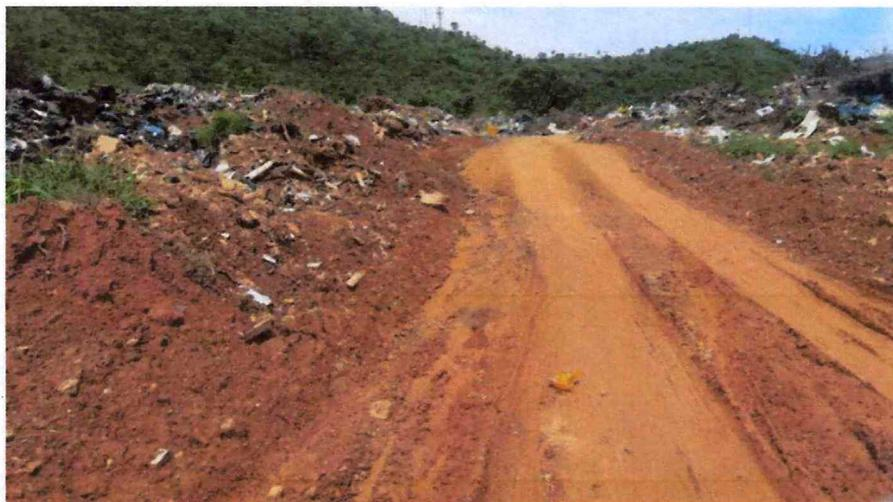
Figura 47 - Vista do interior da ÁREA 01 a partir de um ponto central do terreno, aonde se nota a grande quantidade de resíduos de construção civil depositados a céu aberto. (Foto tirada em dezembro/2018). Fonte: Novo Mundo Engenharia
