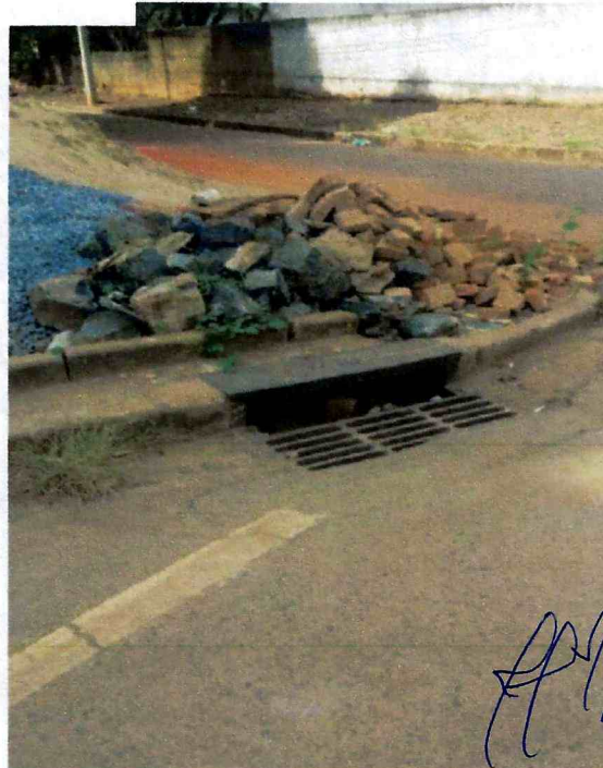
Figura 49- Resíduos de Construção Civil nos bueiros.
