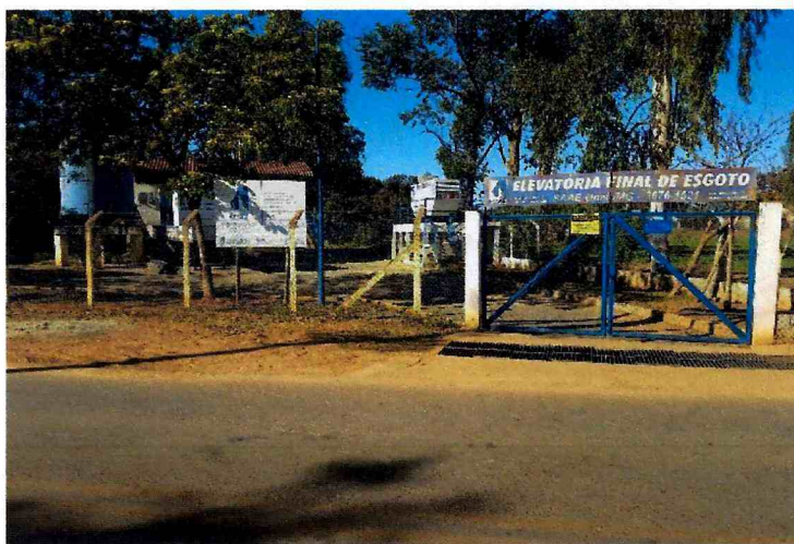
Figura 20-Estação Elevatória de Esgoto EEE de Unaí.
