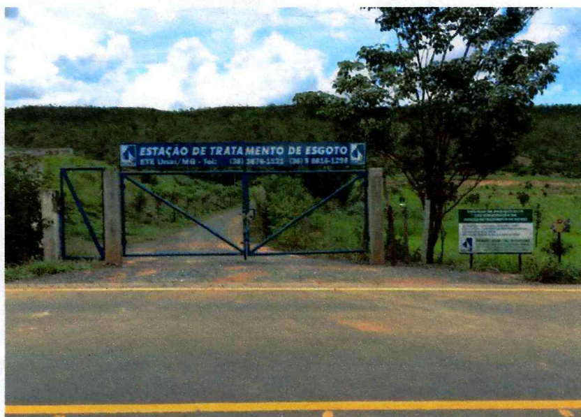
Figura 25-Entrada da ETE Unaí.
