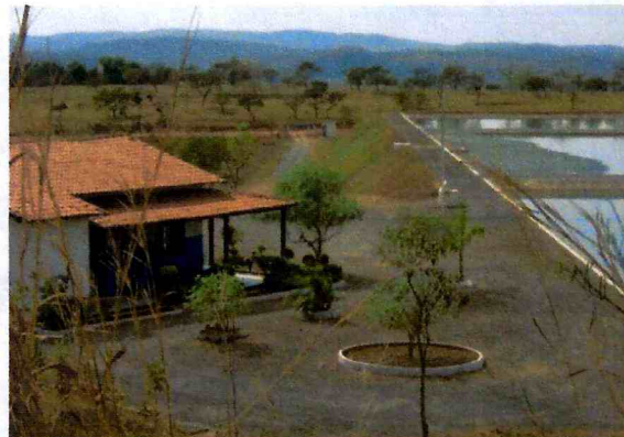
Figura 32- Edificações existentes, paisagem, via de acesso, guarita ao fundo.
