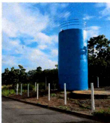
Figura 16-Reservatório de Água do Bairro Novo Jardim em Unaí
