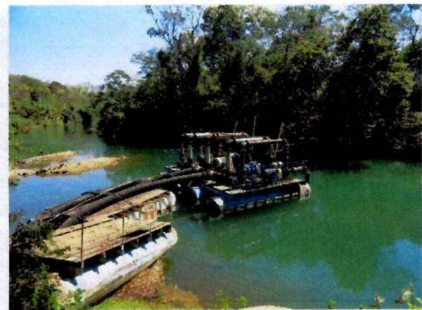
Figura 8-Captação de água bruta no rio Preto e bomba flutuante.
