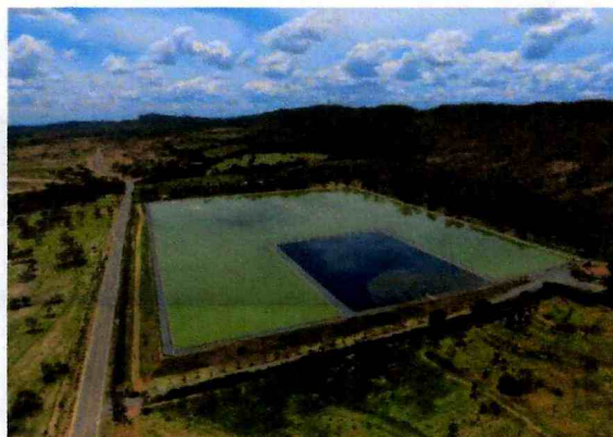
Figura 28- Vista aérea das lagoas: menor anaeróbia
