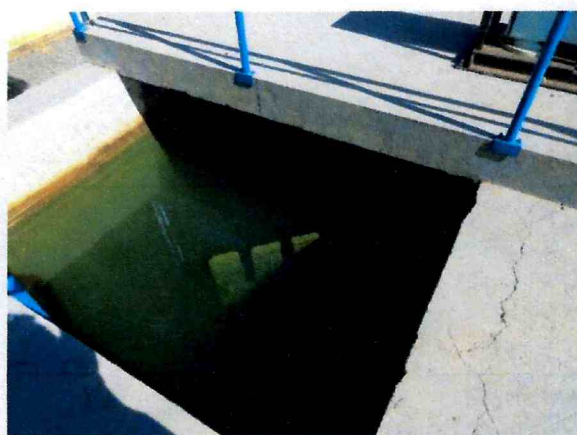
Figura 11-Floculadores tipo paletas.
