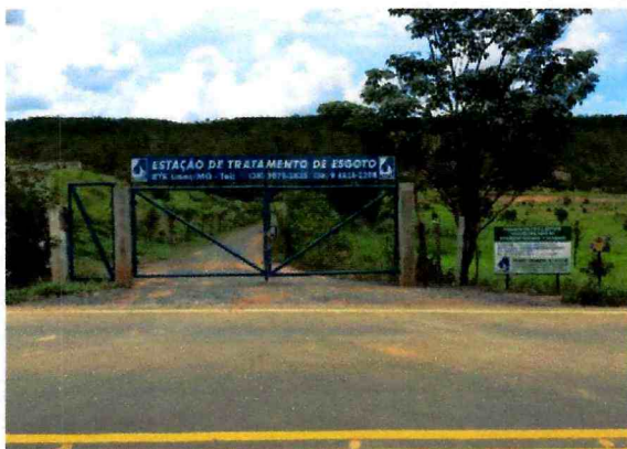
Figura 27-Ponto de entrada da ETE Unaí
