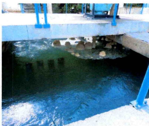
Figura 11-Floculadores tipo paletas.
