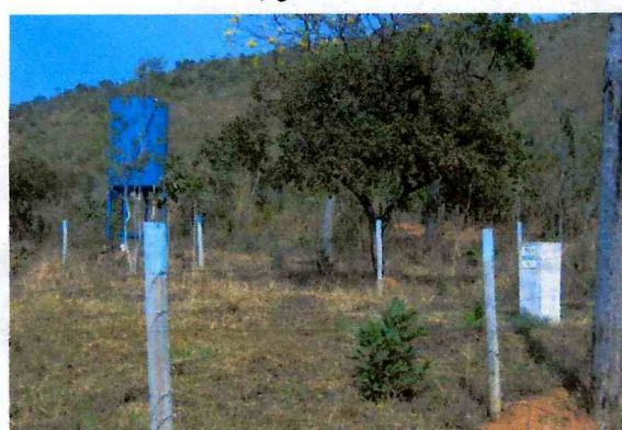
Figura 34- ETE: reservatório, poço de monitoramento nº. 1, cerca dos limites.
