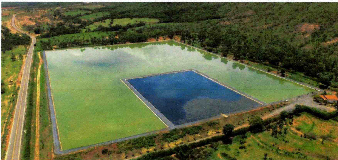
Figura 24-Imagem aérea da ETE.
