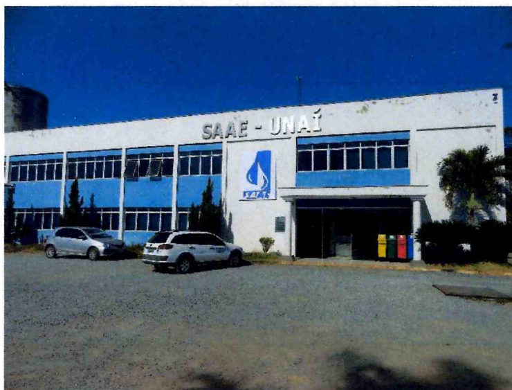
Figura 6-Estação de Tratamento de Água - ETA Saae Unaí.
