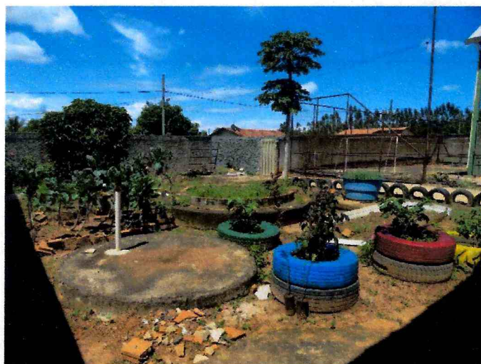
Figura 44-Fossa rudimentar em escola do Distrito de Garapuava.
