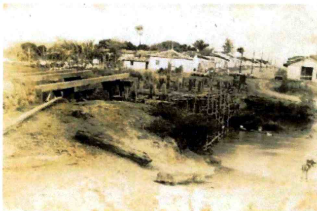
Figura 6: A antiga ponte de madeira sobre o Rio Preto
