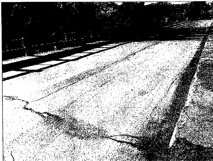
Foto 5 – Vista superior evidenciando trinca no pavimento na região da junta longitudinal das obras.
