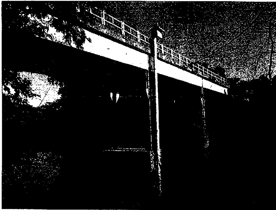
Foto 3 – Vista lateral de jusante (lado Unai). Em primeiro plano está a ponte mais recente, construída em 1988.
