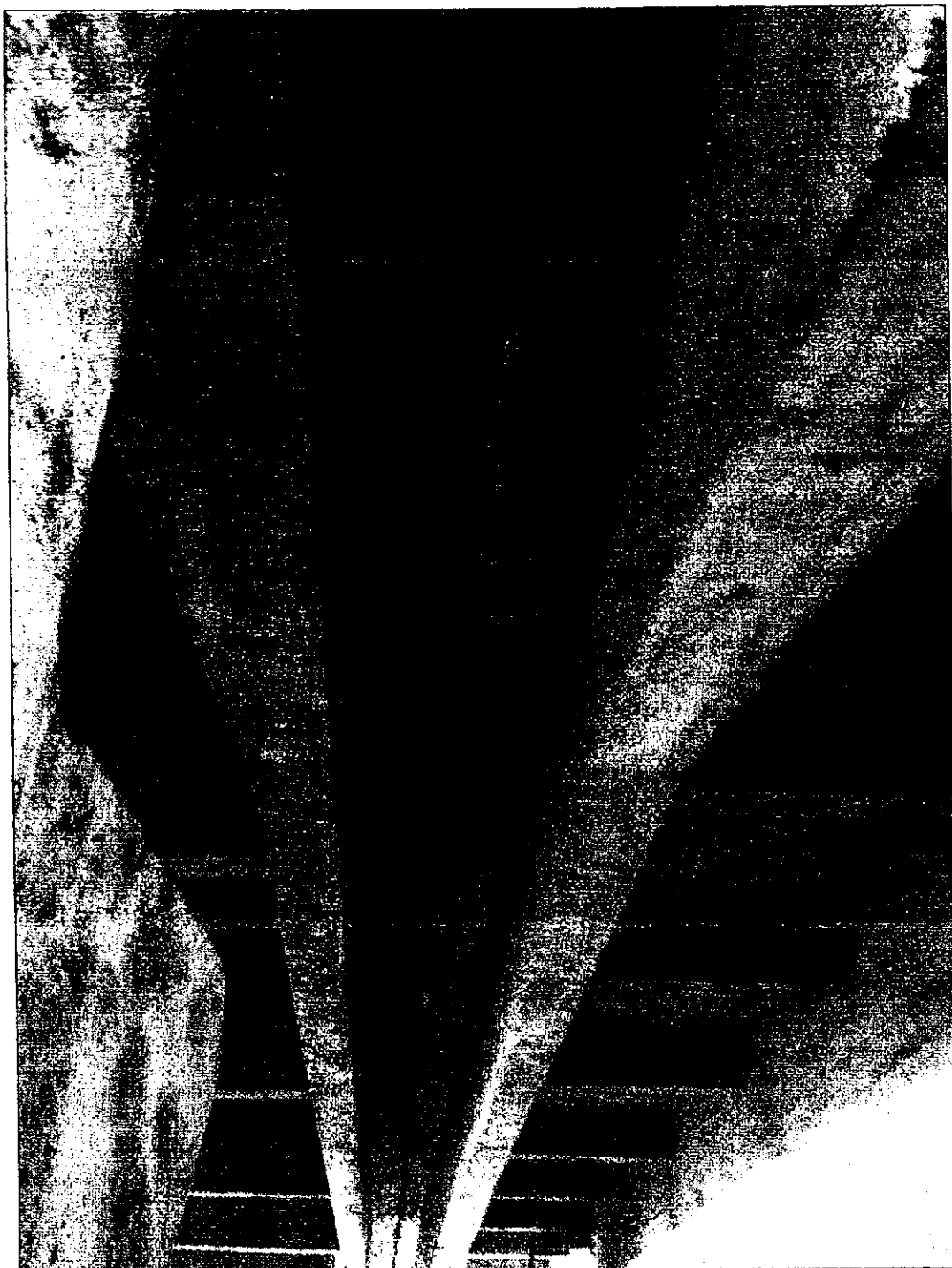
Foto 9 – Vista inferior mostrando a junta longitudinal das duas obras. Não foi observada nenhuma abertura ou movimentação da junta.
