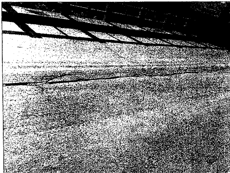
Foto 6 – Vista superior evidenciando trinca no pavimento na região da junta longitudinal das obras.
